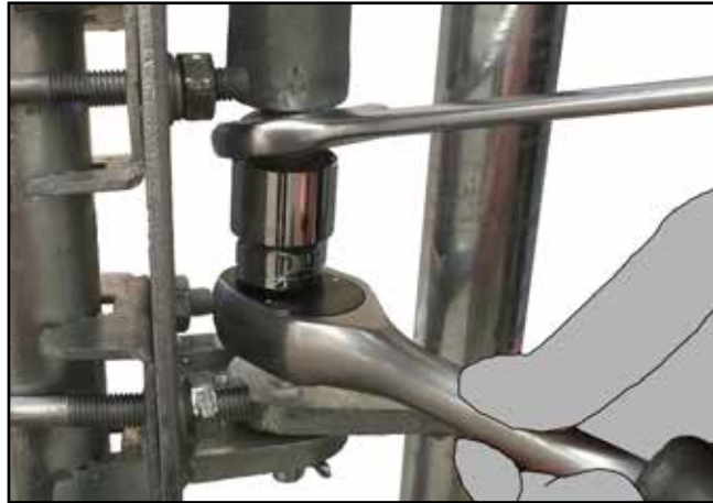
M. Draai de bout met een dopsleutel en ringsleutel van 24 mm vast totdat de poort geheel sluit. (De dopsleutel moet eventueel worden vastgehouden als de ratel wordt gebruikt). Zodra de poort geheel is gesloten, de borgmoer vastdraaien zodat de spanning in stand wordt gehouden. Let op: Blijf de ratel stevig vasthouden en laat deze pas los als de borgmoer is vastgedraaid. Herhaal indien nodig om er zeker van te zijn dat de poort voldoende sluit.
