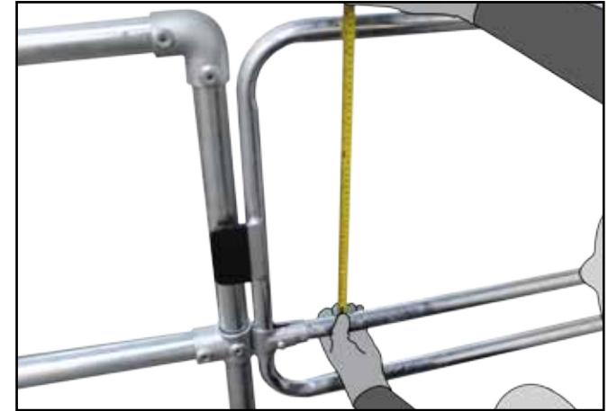
Q. Meet altijd de afstand tussen de midden regel en de boven regel. De afstand tussen beide mag nooit meer zijn dan 470mm.
